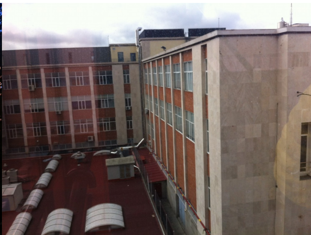
Budynek główny uczelni
